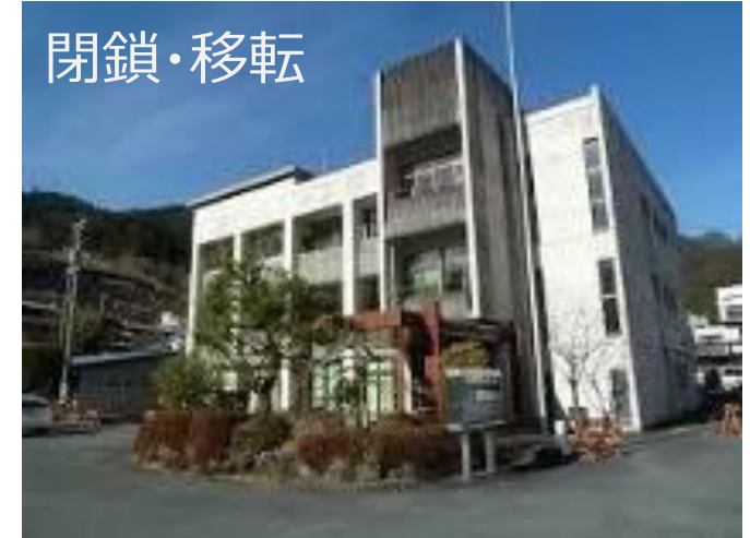
■ 水窪地域自治センター（旧水窪町役場） … 移転廃止 2010(H22)
