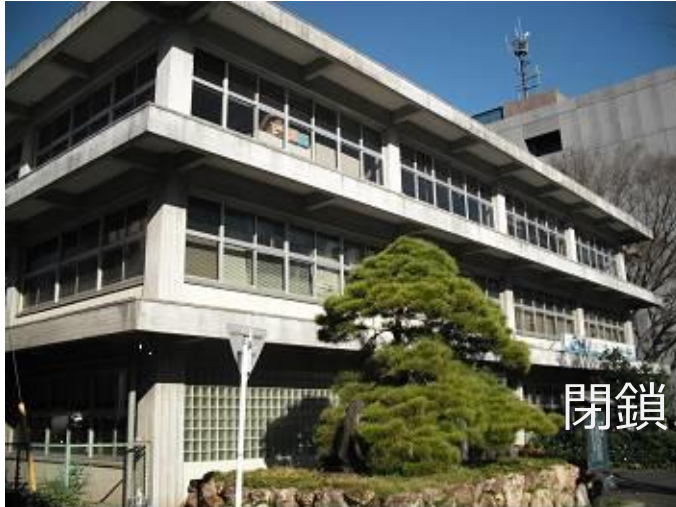
■ 本庁舎・西別館 … 解体・公園用地活用 2010(H22)
