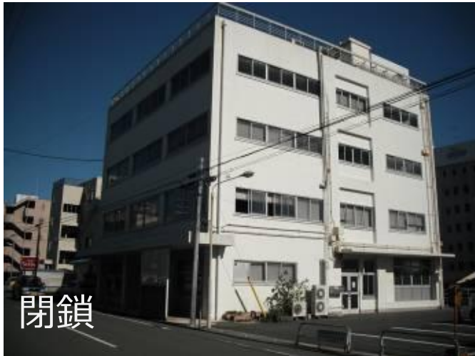
■ 本庁舎・南別館… 解体・処分 2010(H22)
