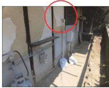
浸水により塗土の半分が剥落している。
