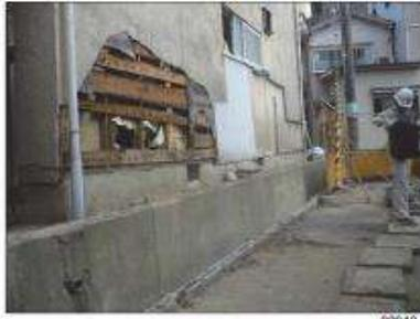
仕上材が剥落しており、下地材に破壊が生じている。
