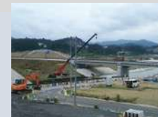
高台に囲まれた防災庁舎
